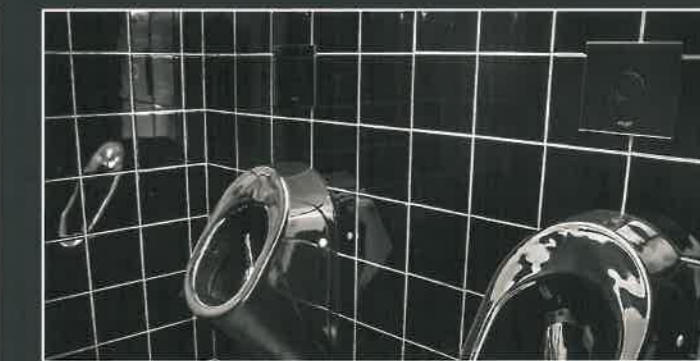
Uninoirbedieningsplaat Visign for More 100 met aanrakingsloze infraroodactivering.
