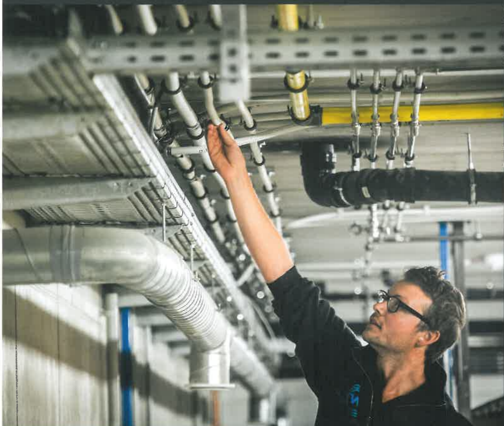
Afb. 1: Lus van Pexfit Pro-leidingen met aparte aftappunten, en Sanpress Inox voor perslucht, zuurstof en stikstof.
