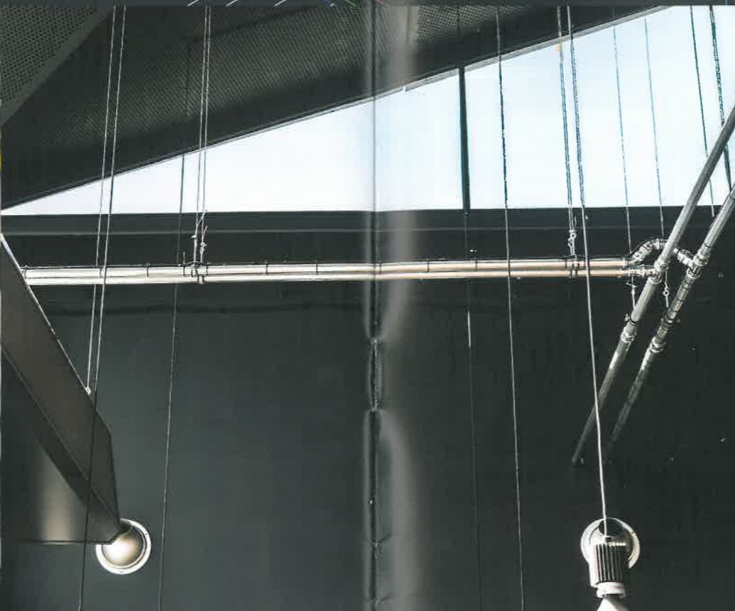
Afb. 2: Prestabo voor water en warme lucht.
